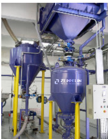
Centro de testes / Test Center Centro tecnológico
