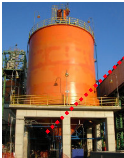
Silo com descarga fluidizada Fluidized discharge silo
