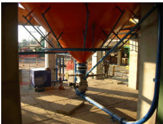
Transporte pneumático em fase diluída/ Pneumatic conveying dilute phase
