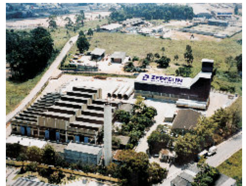
Vista aérea da fábrica / Plant overview Vista aérea de la fábrica
