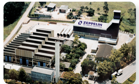
Vista aérea da fábrica. Plant overview. Vista aérea de la fabrica.
