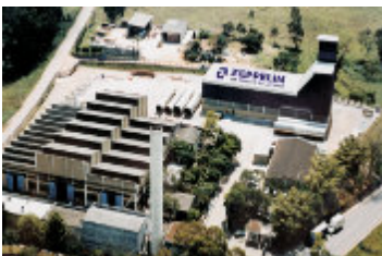
Vista aérea da fábrica / Plant overview Vista aérea de la fábrica
